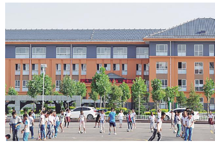
林州市第七小学“全面改薄”项目新建的教学楼
